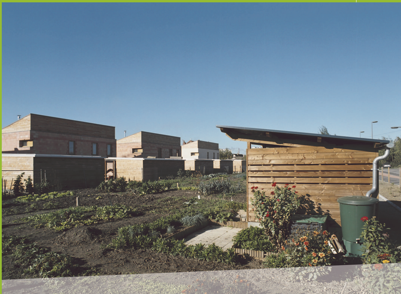
Les jardins ouvriers et la récupération des eaux de pluie
