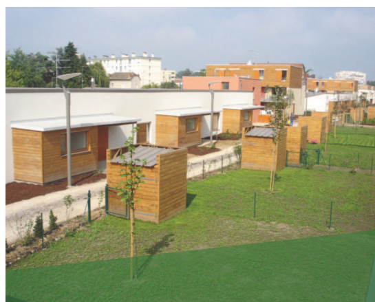
L'allée centrale et les logements individuels
