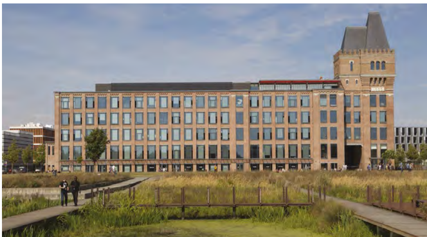
ÉcoQuartier des rives de la haute Deule : la réhabilitation du bâti et des espaces publics dévoile la richesse du patrimoine industriel local
