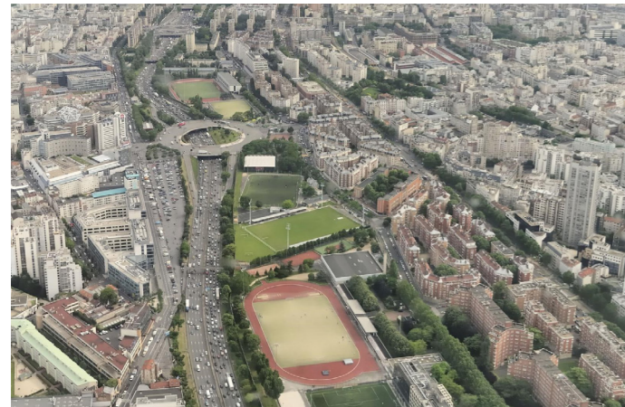
Vue aérienne du quartier des Portes du XX ème , n.d., ©Paris Habitat
