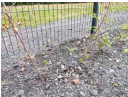
Passage à faune - clôture surélevée.
