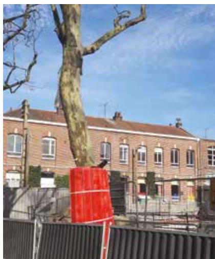
Protection d'un arbre sur le chantier.
