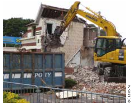
Chantier de déconstruction.
