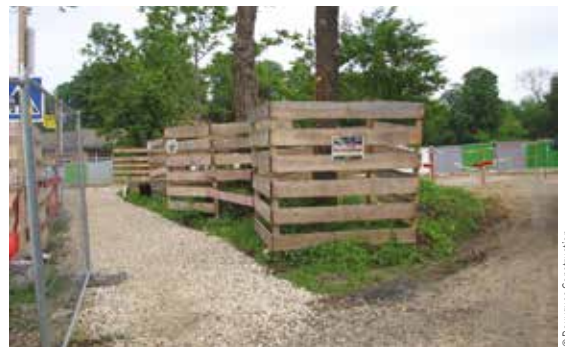
Balisage du chantier.
