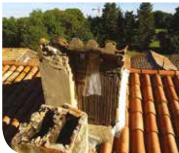
Dispositif anti-retour de type chaussette.
