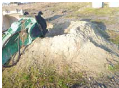
Tas de sable créé sur le chantier.
