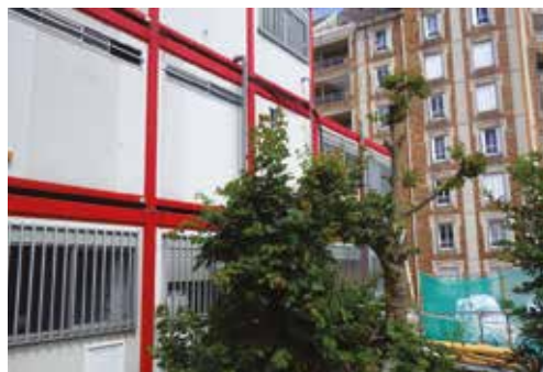
Taille drastique d'un arbre non préservé pour le positionnement de la base de vie d'un chantier.
