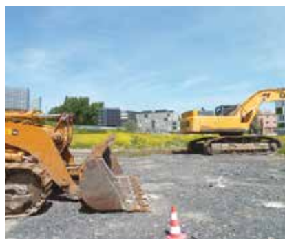
Gestion du parking des engins de chantier.
