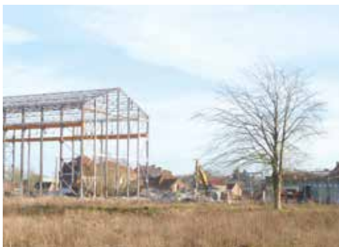
Hêtre maintenu après la déconstruction.
