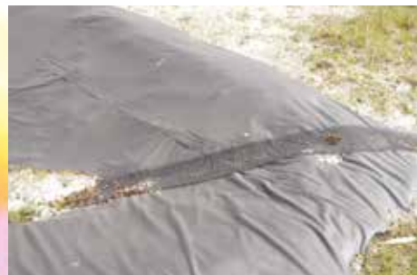
Rampe pour vertébrés, bassin tamponnement.
