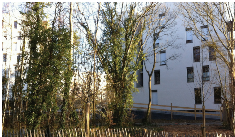
Les arbres existants ont été conservés dans la ZAC La Courrouze à Rennes
