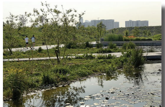
Le Parc du Chemin de l'Île à Nanterre est un aménagement d'espace public développé par la Société Phytorestore comprenant des zones humides artificielles (les jardins filtrants) destinées au renouvellement de l'eau de la Seine.
