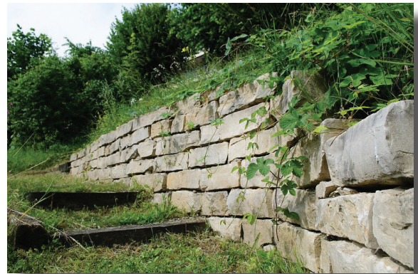
Murets servant de refuge notamment pour les reptiles
