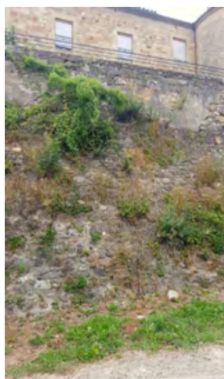
Mur de soutènement.
